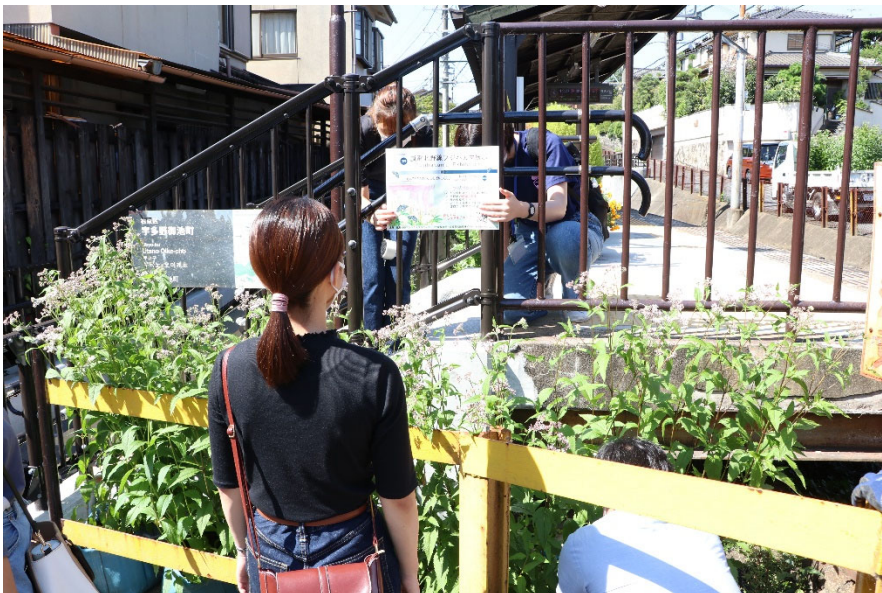
2021年嵐電北野線での設置作業の様子
