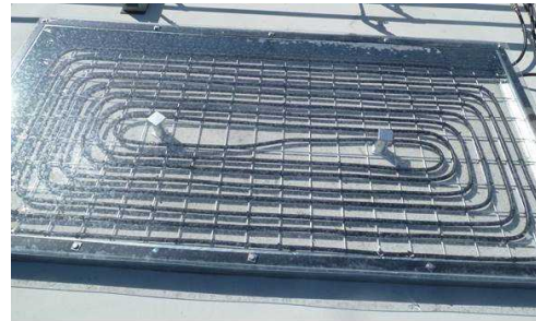
トリシアの雨水調整型ランドスケープデザイン（左）、屋上の太陽熱利用パイプ（右）
